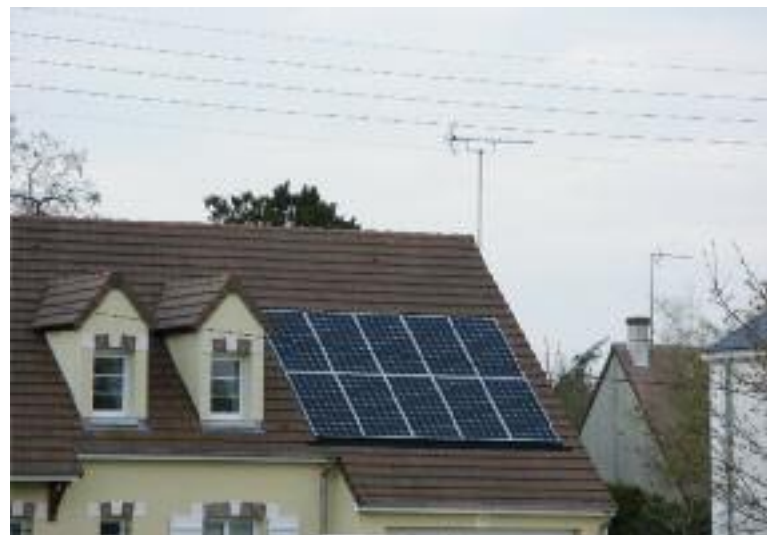
Fig. 154 : Impact visuel de panneaux solaires en milieu de toiture, contrastant avec le matériau de couverture.
