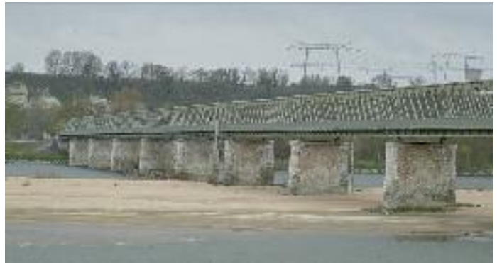
Fig. 130 : Structure en caisson métallique : une masse imposante, une vue sur le fleuve difficile.
