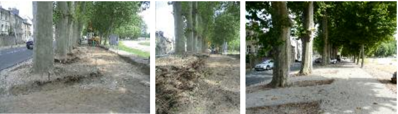
Fig. 35 : Décapage au pied d'un alignement de platanes le long d'un mail en front de Loire pour créer parkings et voirie en béton. A droite, vue après travaux.
