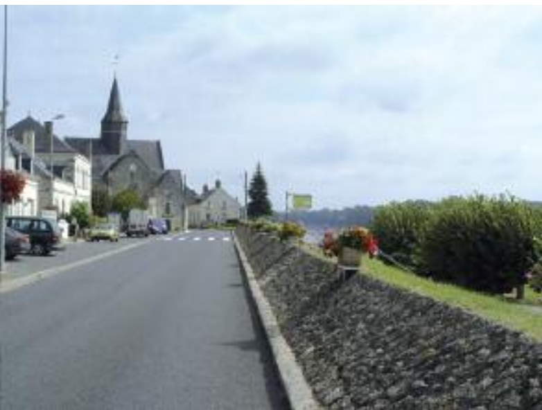
Fig. 198 : Talus avec perré à flanc de digue et rampe d'accès, talus avec perré en sommet de levée.
