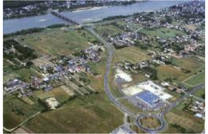
Fig. 134 : Le projet de franchissement : un programme global devant traiter l'ouvrage, ses abords et le territoire traversé.
