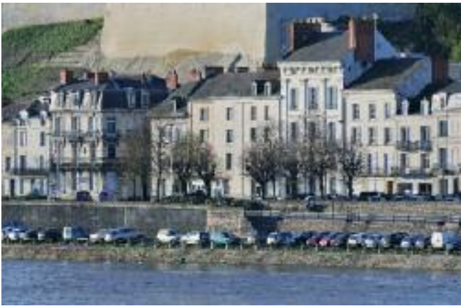
Fig. 117 : Façades des maisons de quai alignées sur le fleuve.
