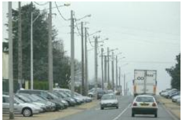
Fig. 146 : Multiplication des réseaux le long d'un axe routier majeur : banalisation de l'approche et dégradation du site.
