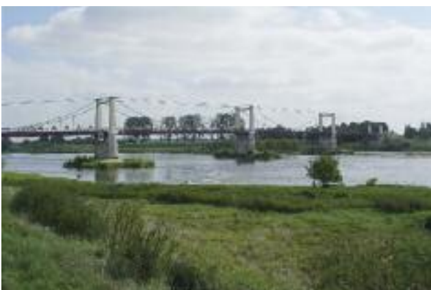
Fig. 128 : Les ponts métalliques suspendus : une silhouette et une présence caractéristiques du Val de Loire.
