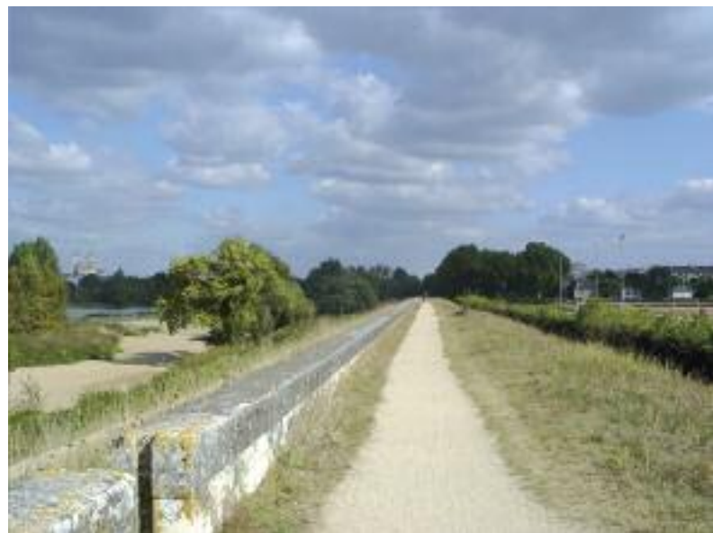
Fig. 198 : Talus avec perré à flanc de digue et rampe d'accès, talus avec perré en sommet de levée.
