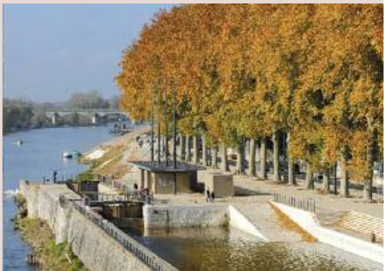
Fig. 46 : Réaménagement contemporain des quais et réouverture sur le fleuve.
