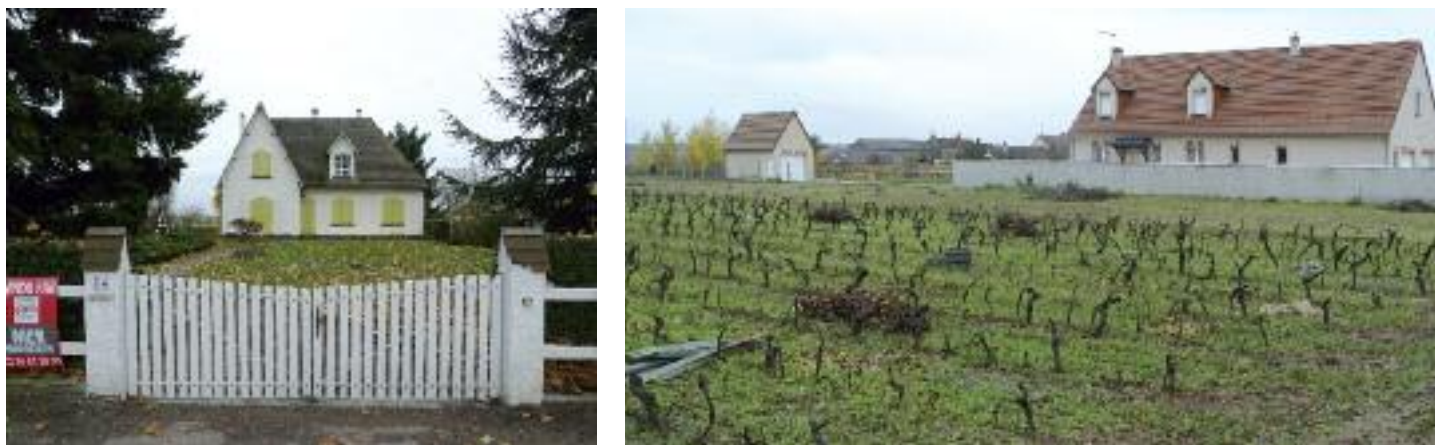
Fig. 122 : Exemples courants de banalisation des constructions et absence d'intégration dans leur environnement.
