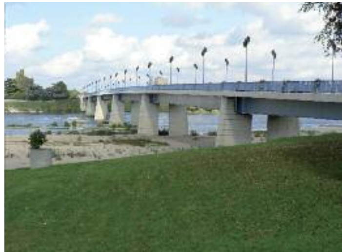
Fig. 132 : Une structure de tablier épaisse qui alourdit la silhouette de l'ouvrage. Une prégnance trop forte de l'éclairage.
