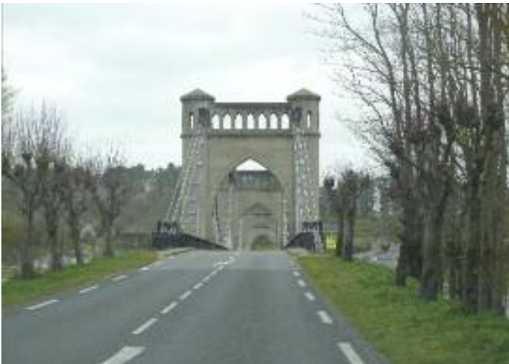
Fig. 131 : L'habillage des piles surcharge considérablement l'ouvrage et crée un effet pastiche.
