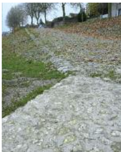
Fig. 40 : Rejointoiement en béton sur le tablier pavé du quai.
