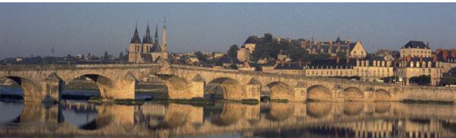
Fig. 32 : Les nombreux édifices historiques, châteaux, abbayes, fronts bâtis des villes historiques, marquent de leur présence le Val de Loire et composent avec le fleuve un ensemble paysager remarquable.
