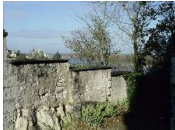
Fig. 118 : Tuffeau, pierre de taille et enduit à la chaux pour réaliser ce muret.
