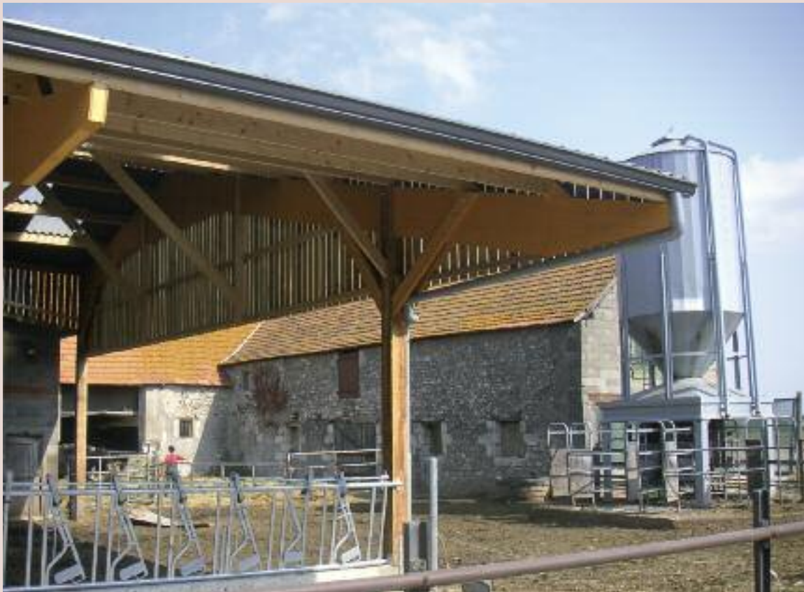
Fig. 76 : Bâtiments en bardage bois, composés autour d'une cour. Le travail a porté sur l'implantation, le choix des matériaux (bardage bois) et sur les entrées.
