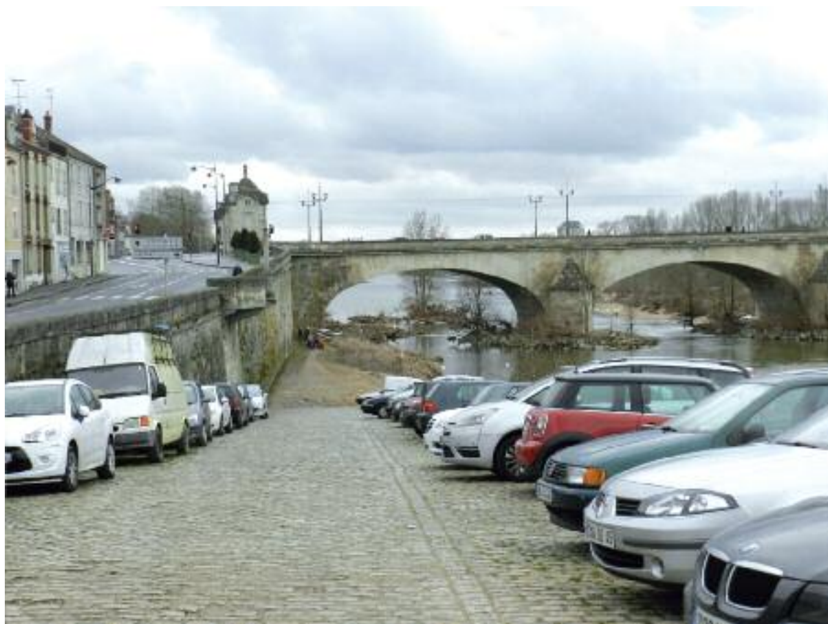
Fig. 44 : Les bords de Loire sont envahis par les stationnement de véhicules, ce problème est récurrent sur l'ensemble du site.
