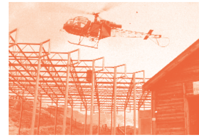
Acheminement par hélicoptère des modules tridimensionnels sur le chantier. © Jean Masson.
