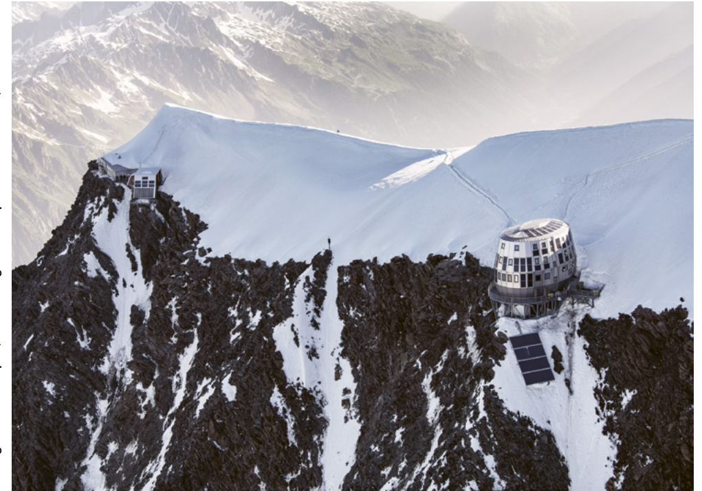
Sur l'arête du Goûter, de gauche à droite, le refuge de 1961, le dortoir complémentaire (1989) et le refuge actuel (2011). © Franck Trabouillet, Région Auvergne-Rhône-Alpes, Inventaire général du patrimoine culturel, 2019.
