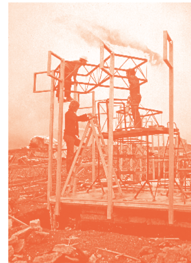
Montage de la charpente aluminium et des panneaux « Matra ». © AAM-Guy Rey-Millet.
