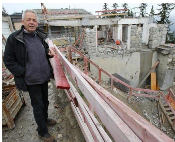
En 2013, Jean-François Lyon-Caen était monté à Courchevel pour superviser la déconstruction du chalet, sous la maîtrise d'œuvre du cabinet d'architecture Repiquet-Briolle.
