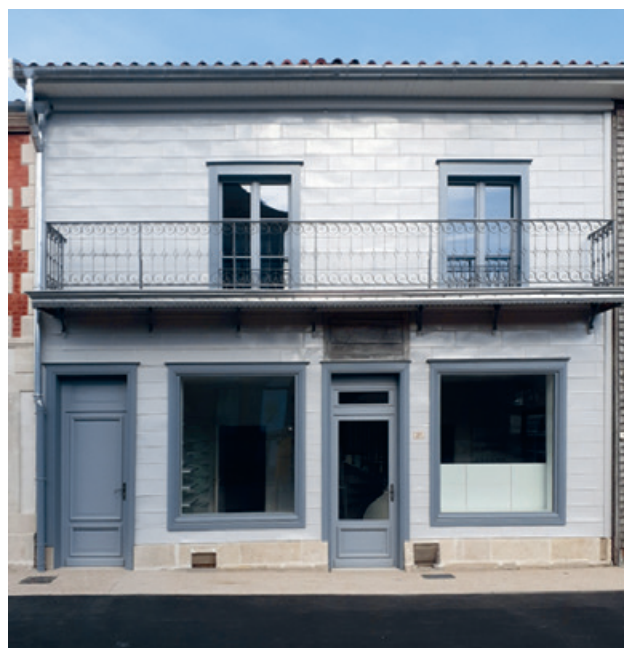
La façade après réfection © Mairie de Chavanges
