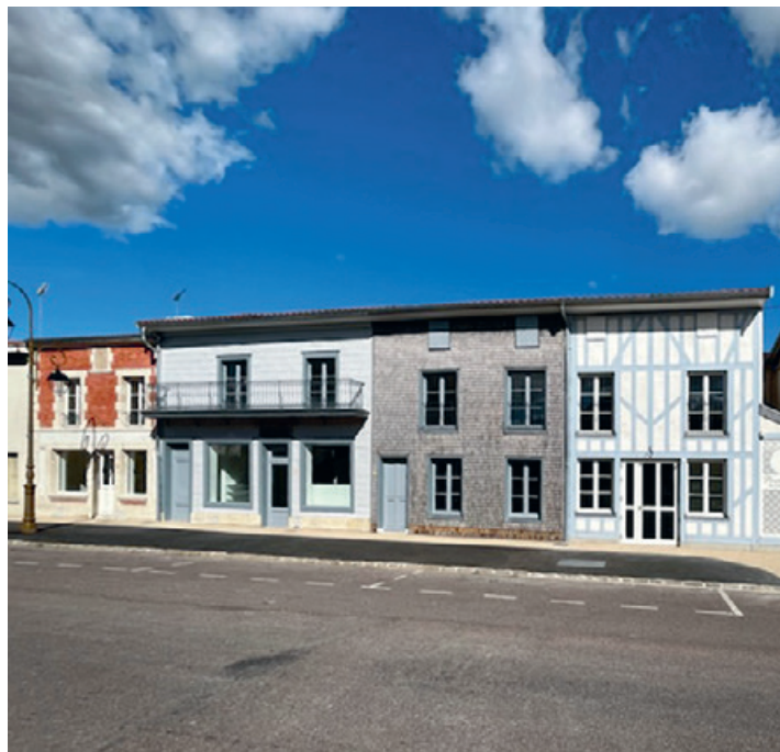
Quatre façades pour un même bâtiment © Mairie de Chavanges
