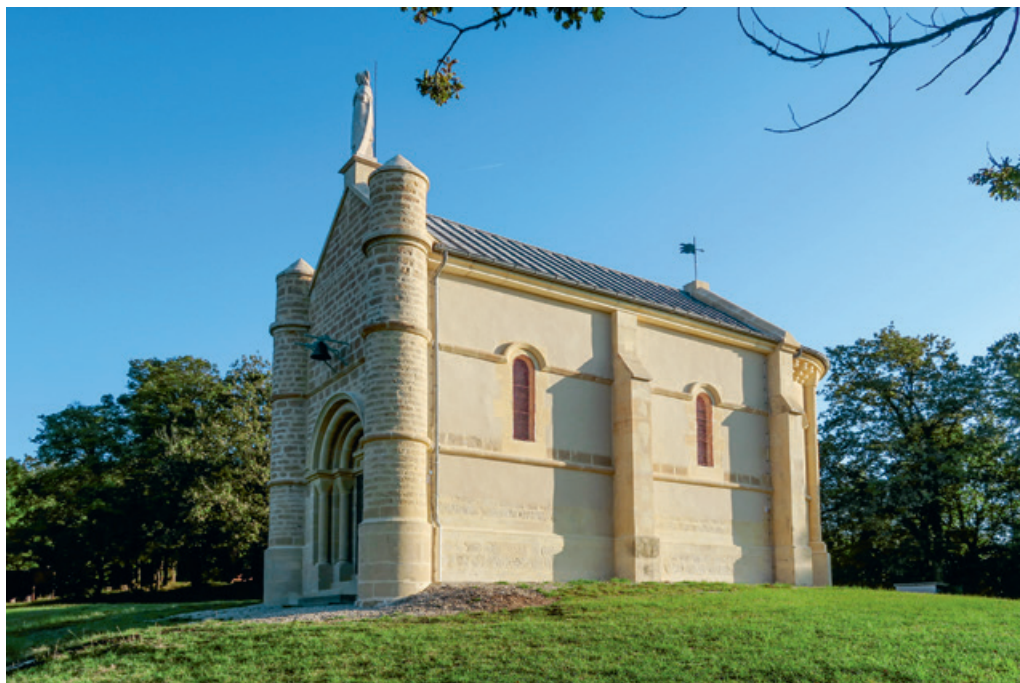
La chapelle restaurée, au sommet de la colline de la Tête-Ronde © Mairie de Menou / Th. Deweerdt
