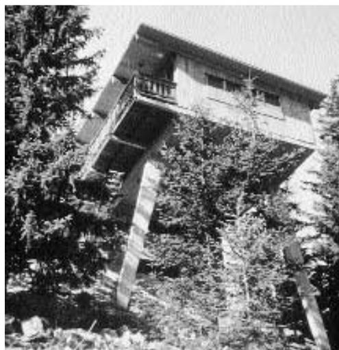
La façade principale sud-est est longée par le balcon en bois, comprenant un escalier extérieur escamotable. Les menuiseries extérieures sont équipées de volets d'occultation : contrevents coulissants verticalement devant l'allège faits en bois de contreplaqué recouverts d'aluminium.
