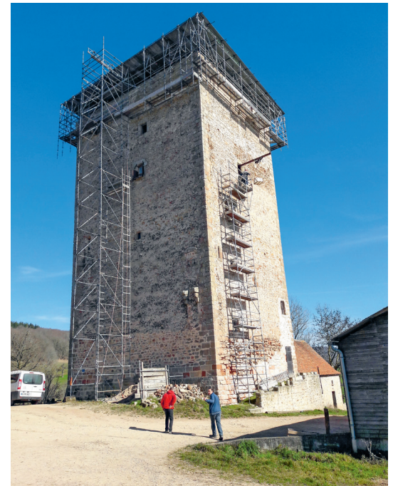
Vue générale de la tour du Bost en 2019. © Tremplin H&P
