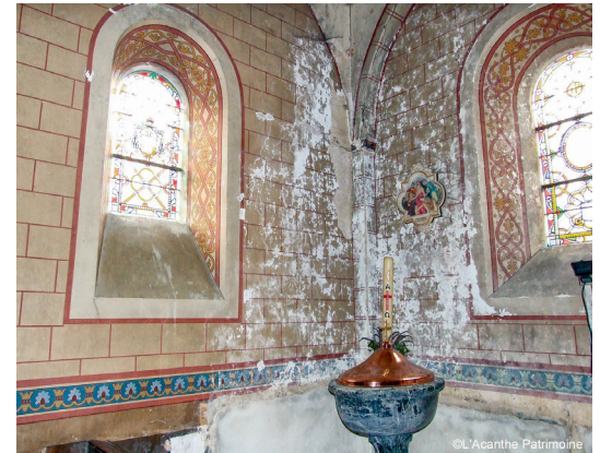
Ci-dessus : Église Notre-Dame-de-l'Assomption (Chéméré-le-Roi), vue du bas-côté sud avant les travaux.
