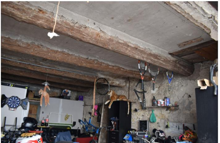
Fig. 10 : Plancher d'étage de type « provençal », vue depuis le nord-ouest (cliché C. Auburtin)
