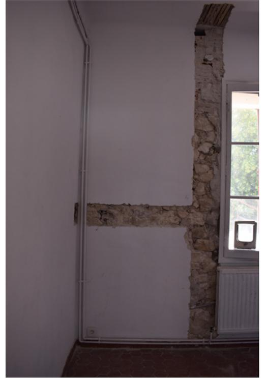
Fig. 2 : Sondage 4 : Parement intérieur du mur MR 2 à l'étage. À 2,35 m du sol, l'arase du mur MR 2 est surélevée par des assises de briques creuses, vue depuis le nord (cliché C. Auburtin)
