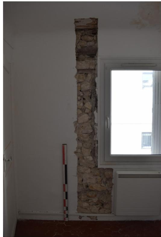
Fig. 6 : Sondage 9 : Maçonnerie du mur MR 8 fermant l'espace 202 au nord, dans lequel est aménagée une fenêtre dont reste visible le piédroit est de son cadre façonné au mortier, vue depuis le sud (cliché C. Auburtin) (cliché C. Auburtin)
