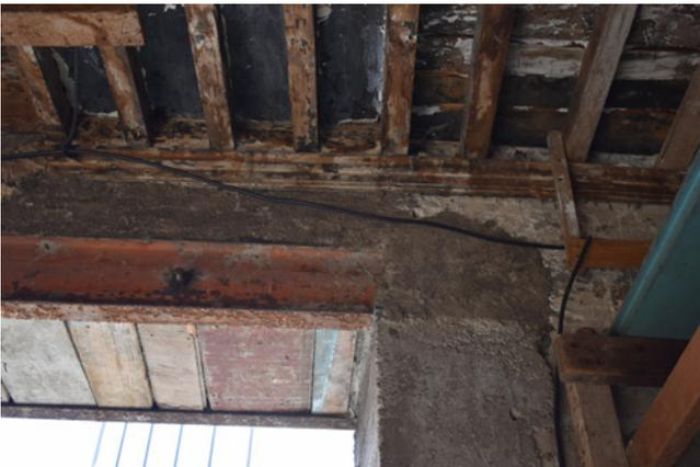
Fig. 6 : Insertion des solives du plafond dans le mur MR 12 en partie haute, au dessus de la grande ouverture réalisée à peine plus bas dans la maçonnerie, vue depuis le sud (cliché C. Auburtin)
