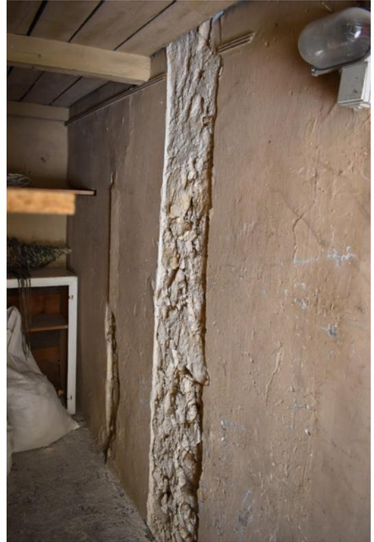
Fig. 4 : Sondage 6 : Maçonnerie hétérogène de petits moellons non assisés liés au mortier, vue depuis le sud-est (cliché C. Auburtin)
