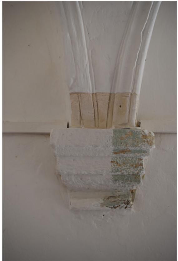
Fig. 17 : Sondage 24 : Bonne conservation des arêtes façonnées dans le mortier de la couverture de la galerie sous l'épais badigeon blanc qui recouvrant l'ensemble des volumes de l'espace 101, vue depuis le nord (cliché C. Auburtin)
