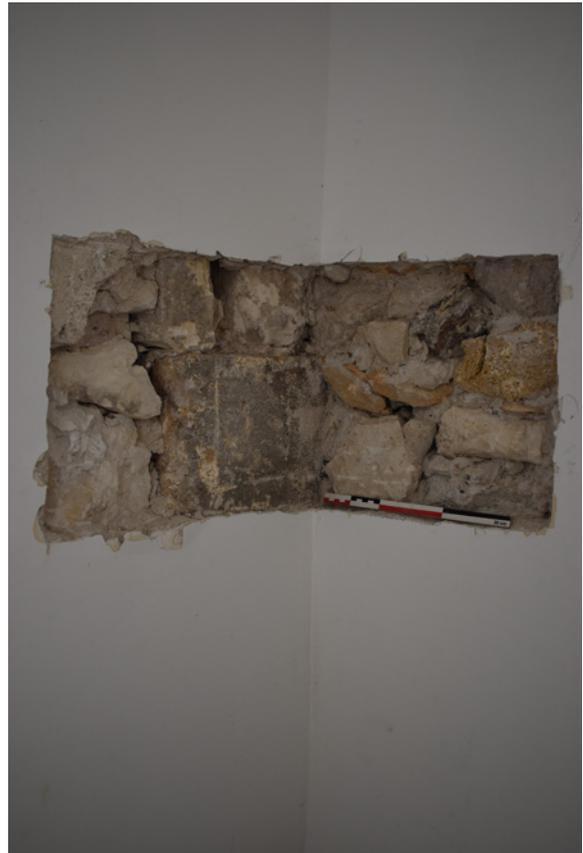
Fig. 3 : Sondage 8 : Maçonnerie du mur MR 8 (à droite sur le cliché) établie en appui sur le chaînage d'angle formé par les élévations de MR 9 et MR 12, vue depuis le sud-est (C. Auburtin)
