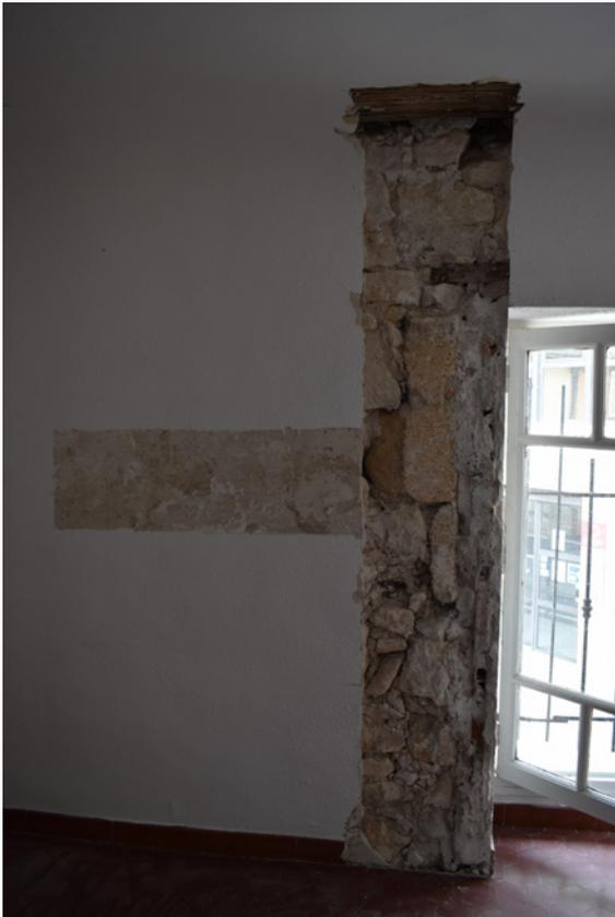
Fig. 3 : Sondage 1 : Maçonnerie du mur MR 12 fermant l'espace 201 au nord, dans lequel est aménagée une fenêtre en pierre de taille dont reste visible le piédroit ouest, vue depuis le sud (cliché C. Auburtin)
