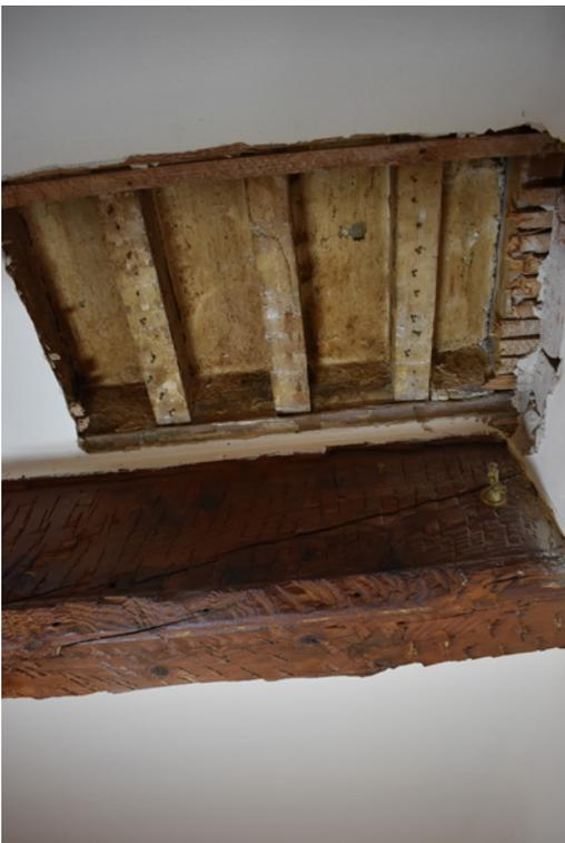
Fig. 8 : Sondage 20 : Surfaces peintes conservées au-dessus du dispositif de cimaises positionnées de part et d'autre de la poutre, vue depuis le sud (cliché C. Auburtin)
