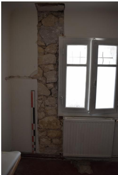
Fig. 5 : Sondage 2 : Continuité et homogénéité de la maçonnerie intérieure du mur MR 12 dégagée sur une hauteur de 2 m, vue depuis le sud (cliché C. Auburtin)
