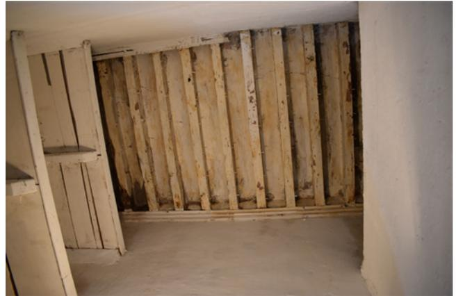
Fig. 7 : Sondage 20 : Plafond à solives dans la moitié est de l'espace 106, dissimulé derrière les placages récents, vue depuis l'ouest (cliché C. Auburtin)
