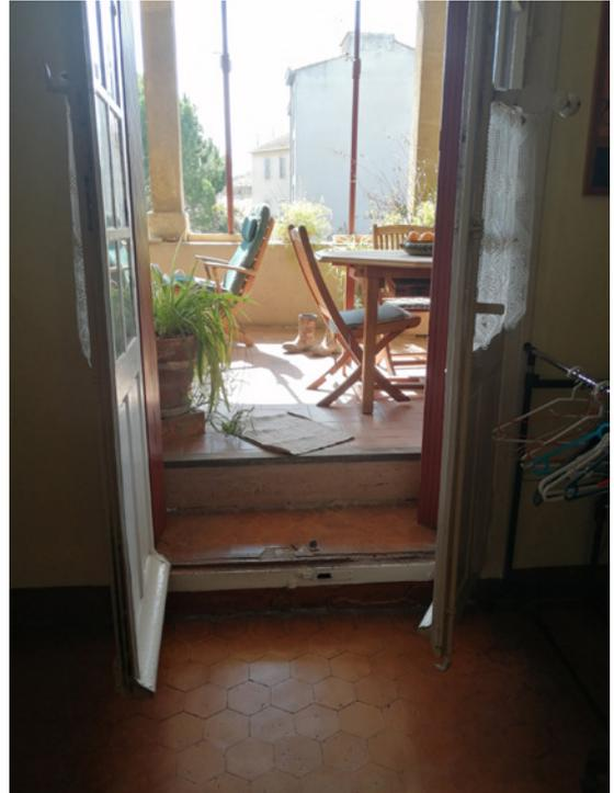
Fig. 4 : Rattrapage de la différence de niveau entre l'espace 203 et la galerie couverte 200 située au sud, par l'aménagement d'une courte volée de marches dans l'épaisseur du mur MR 2, vue depuis le nord (cliché C. Auburtin)
