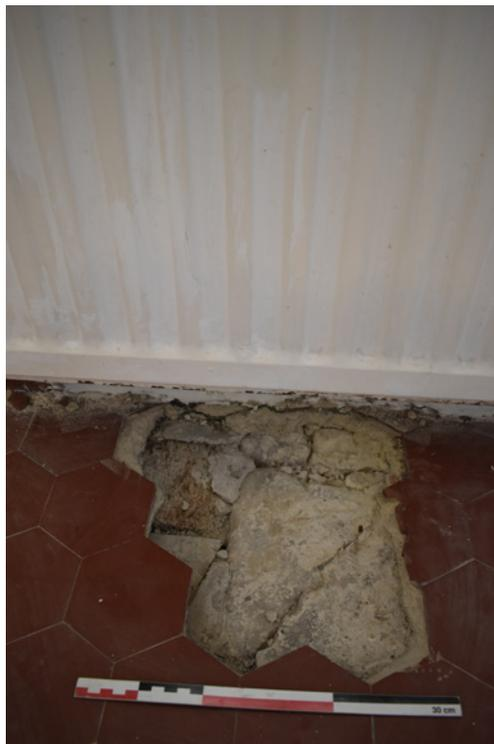
Fig. 7 : Sondage 2 : Sol de mortier aménagé sur le plafond de bois de l'espace 104, vue zénithale (cliché C. Auburtin)
