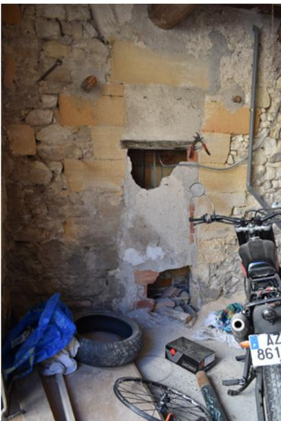
Fig. 4 : Grande porte à encadrement en pierre de taille partiellement colmatée, au nord du mur MR 6, vue depuis l'ouest (cliché C. Auburtin)
