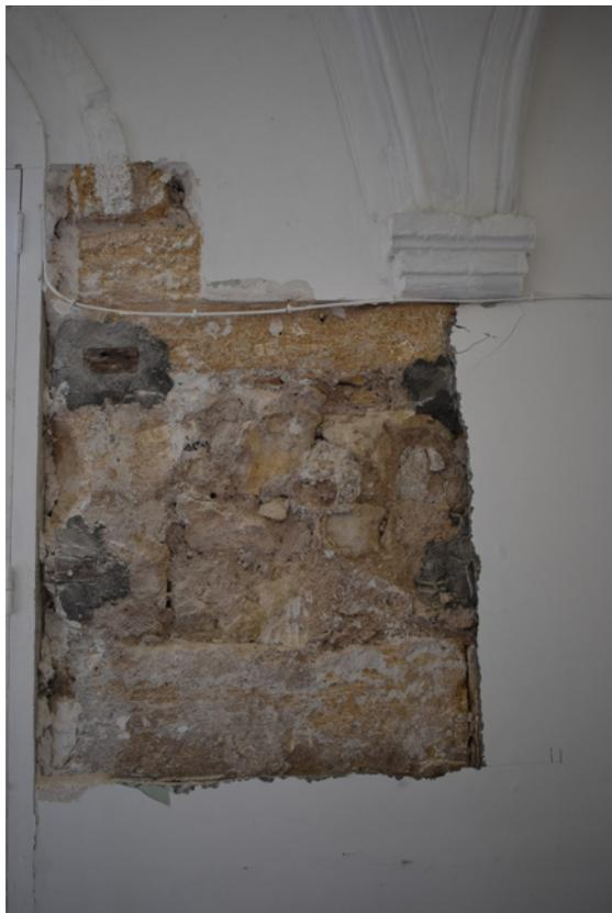
Fig. 7 : Sondage 11 : Mise en œuvre identique au niveau du parement intérieur du mur MR 1. Les moulurations intérieures de l'arcature plein-cintre sont partiellement bûchées, depuis le nord (cliché C. Auburtin)
