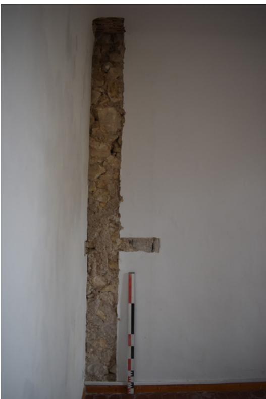
Fig. 4 : Sondage 7 : Continuité et homogénéité de la maçonnerie intérieure du mur MR 6 dégagée sur une hauteur de 3 m, vue depuis l'est (cliché C. Auburtin)
