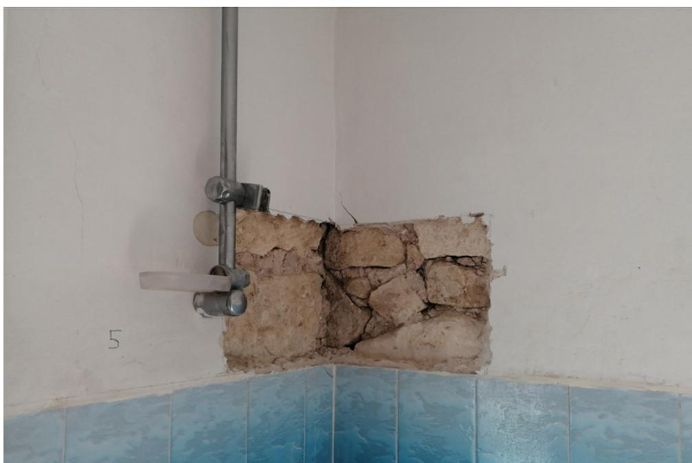
Fig. 6 : Sondage 3 : Chaînage des maçonneries des murs MR 9 est et MR 12 nord, vue depuis le sud-ouest (cliché C. Auburtin)
