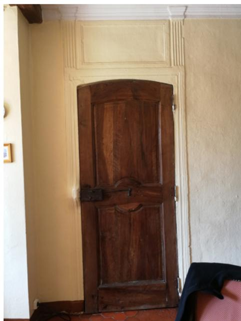
Fig. 2 : Le mur MR 5, établi perpendiculairement, dans l'axe de la galerie 102, est percé d'une ouverture encadrée d'un décor de filets, surmontée d'un cadre-de-porte délimité par des pilastres, vue depuis l'est (C. Auburtin)
