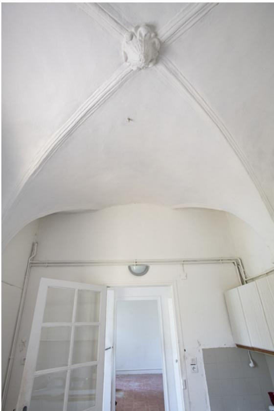
Fig. 14 : Travée couverte de voûtes d'arête surbaissées culminant à 3,50 m du sol, décorée de gypseries sur les arêtes, retombant sur des supports en pierre de taille, vue depuis le nord (cliché n° 20221300246NUC2A, © Région Provence-Alpes-Côte d'Azur - Inventaire général - Jean-Pierre Garufi, 2022)
