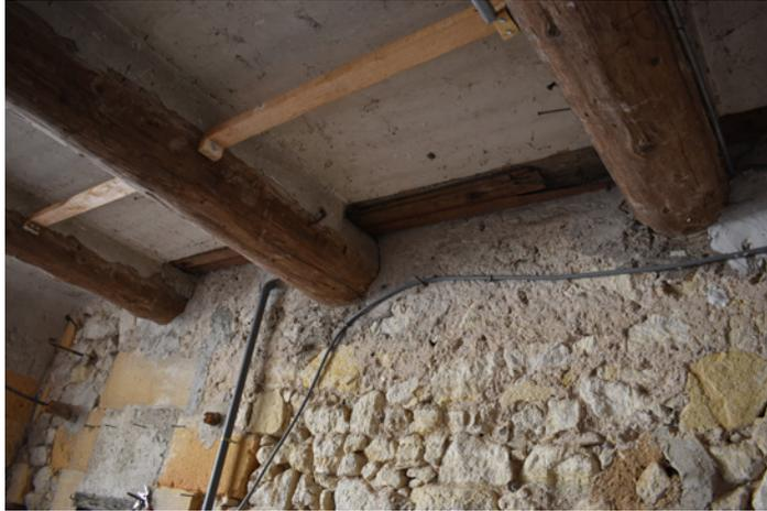
Fig. 11 : Insertion de la nouvelle poutraison dans le bâti ancien, vue depuis le sud-ouest (cliché C. Auburtin)
