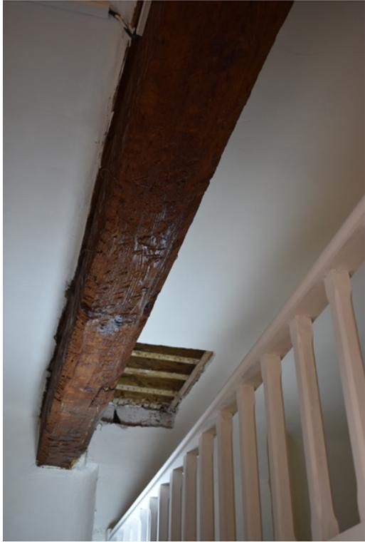
Fig. 10 : Vue de l'une des poutres supportant le solivage du plafond dissimulé derrière un cloisonnement récent, vue en contre-plongée (cliché C. Auburtin)
