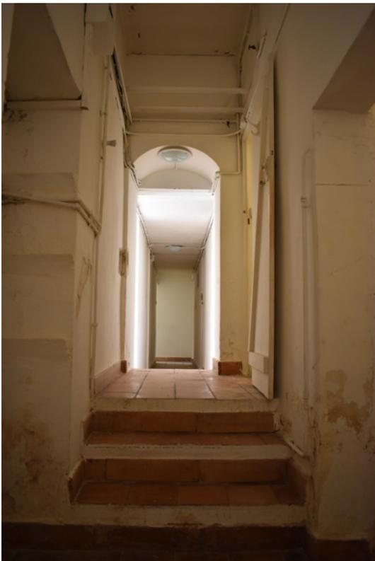
Fig. 2 : Étroit couloir 103 d'aspect hétérogène. Au premier-plan, le massif qui marque une rupture dans le niveau de circulation, au dessus, l'ouverture aménagée dans le mur MR 6, limite ouest de la cellule 106, qui vient s'ancrer dans le mur MR 2, vue depuis l'est (cliché C. Auburtin)
