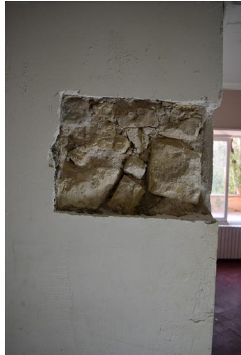
Fig. 5 : Sondage 15 : maçonnerie du mur MR 2 employant différents modules de moellons calcaires non assisés, vue depuis le nord (cliché C. Auburtin)
