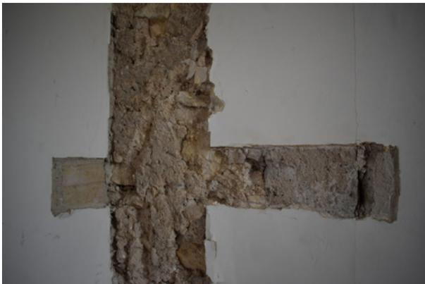
Fig. 5 : Sondage 7 : Détail des réaménagements liés au mur MR 6. Au sud (droite), une ouverture réalisée à posteriori, au nord (gauche), une cloison de briques creuses délimitant les volumes de l'espace 202, vue depuis l'est (cliché C. Auburtin)
