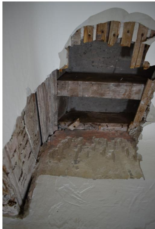
Fig. 9 : Sondage 23 : Plafond à solives dans la moitié ouest de l'espace 106, au contact du mur MR 7, vue en contre-plongée (cliché C. Auburtin)
