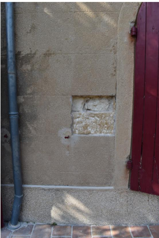
Fig. 6 : Sondage 10 : Blocs en pierre de taille utilisés dans l'encadrement des ouvertures associés à de la maçonnerie de petits moellons pour les surfaces pleines, vue depuis le sud (cliché C. Auburtin)
