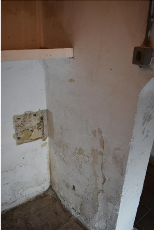
Fig. 6 : Sondage 16 : Liaison du mur-de-refend MR 7 avec l'élévation délimitant au nord l'espace 103, vue depuis l'ouest (cliché C. Auburtin)
