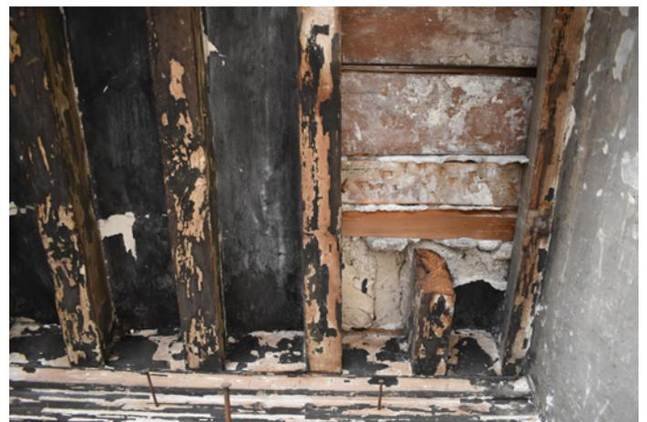
Fig. 13 : Colmatage d'un aménagement pouvant être interprété comme une trémie d'escalier (cliché C. Auburtin)
