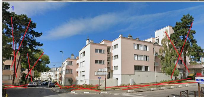
18. Abords de la place Jean Allemane (2e tranche, 1935-1939) et conséquences paysagères de l'intégration à l'« espace circulaire » des jardinets sur rue. Source : Google Street et Sites & Monuments.
