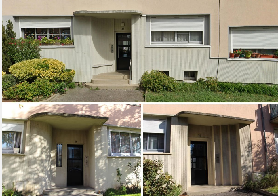
20. Échantillonnage d'entrées Art Déco, toutes différentes, vouées à la démolition (bâtiments nos 27, 31 et 33 de la rue Henri Barbusse). 2e tranche (1935-1939). Source : Google Street et B. Gutglas.
